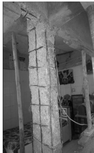
۱- شکل (اوسپنیز کانکریتی تخریب شوی
