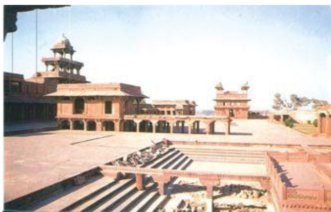
گوشه ای از محوطه ی داخلی فاتح پور سیکری در حال ساخت
