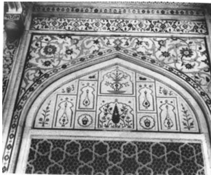
مشبک های ورودی
