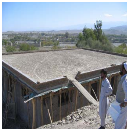
(پورته) اوار کانکریټی بام په قبری غشا او تېرو پت شوی. (پورته ښی طرف ته) د بام کم مائل چوکاټ په کانکریټی slab باندی.
