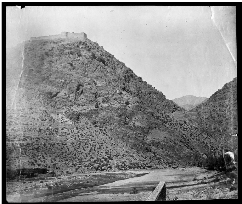
قلعه ی علی مسجد - گذرگاه خیبر
