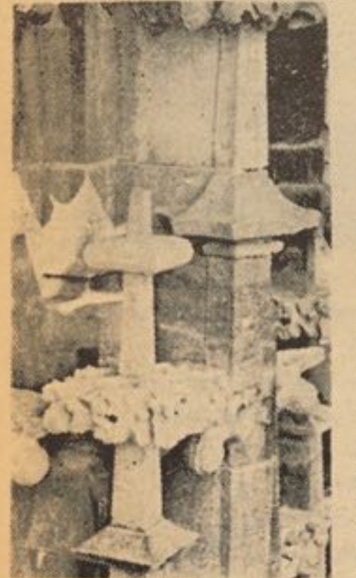
«ماینو رو» یا سنگ مصنوعی که میتواند به اشکال مختلف تهیه گردد . از سنگ های مصنوعی بعضی تر میمانند سنگ های کلیسای لوکوئی استفاده میگردد.
