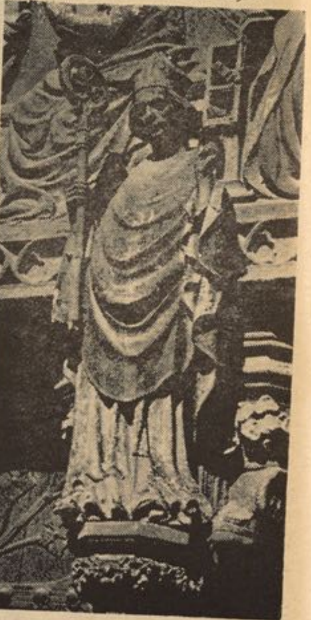
فساد و ساییدگی سنگ ها تنها متوجه شهر های بزرگ نیست بلکه این خطر عام شمول می باشد. مثال زنده این ادعا همین کلیسای هندونی در آلمان می باشد که بچنین یک سر نوشت غم انگیز مبتلا گردیده است.
