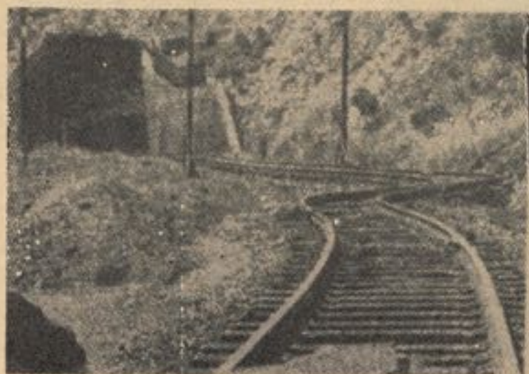
۲- در اینجا ملاحظه می کنیم که بعد از زلزله آگست ۱۹۵۲ گرن کونتی واقع ایالت کلفورنیا، تونل خط آهن ویران و تباب خورده است.
