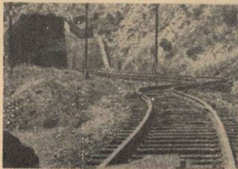
۲- در اینجا ملاحظه می کنیم که بعد از زلزله آگست ۱۹۵۲ گرن کونتی واقع ایالت کلفورنیا، تونل خط آهن ویران و تاب خورده است.
