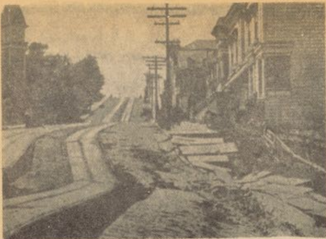
۱- یکی از جاده ها سان فرانسیسکو بعد از زلزله ۱۹۰۶ که زلزله مذکور پوسته سطح زمین را بصورت عمودی وافقی چین داده است .
