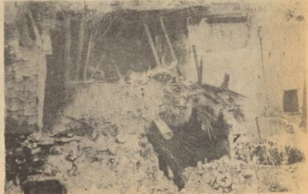
یک منظره از خرابی های زلزله در منطقه تور گل
