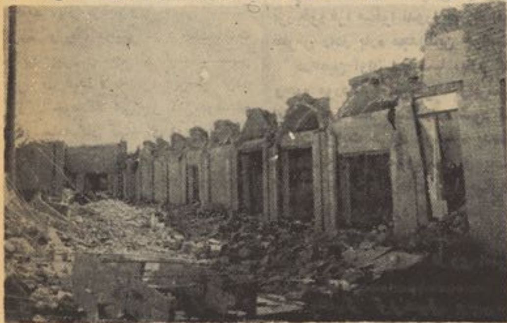
گوشه ای از خرابی های زلزله
