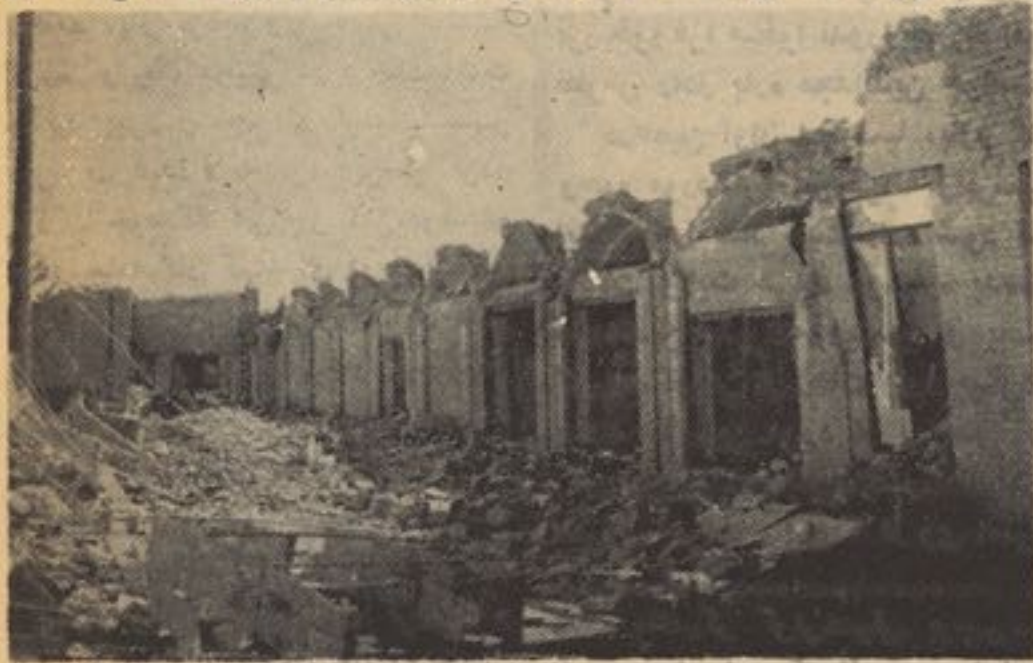
گوشه ای از خرابی های زلزله
