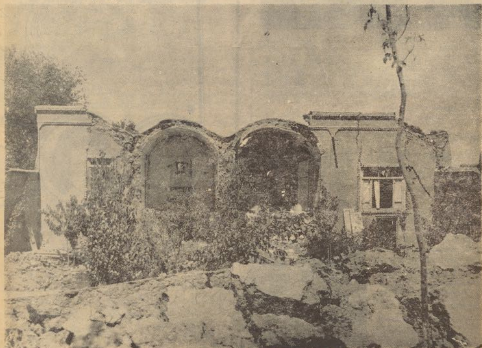
نمای از خرابی های زلزله به مازل مسکونی
