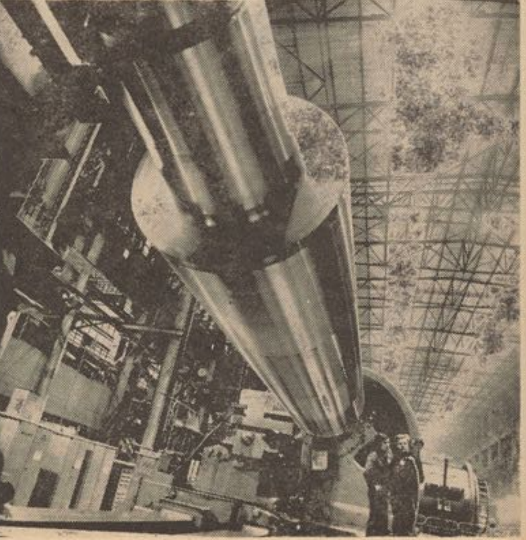
دووسو زرو کیلو واټو په ظرفیت دشوروی اتحاد دپرشنا دجنیریترو ونو دانجنیری دبرخی یوه څنډه .
