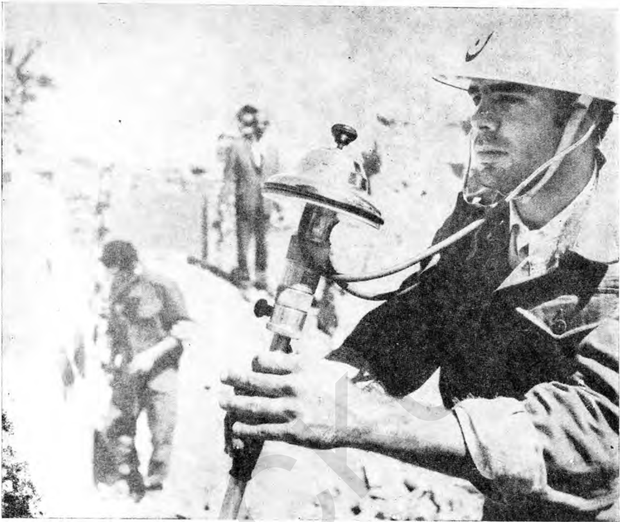
این دستگاه صدای ضربان قلب مجروحین را که در زیر خاک مانده باشند بگوش میرساند
