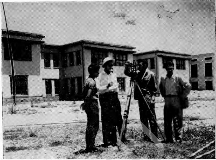
داجنيرى دپوهنځى دودانى يو همنظره چه لمينى شاگردان پكښى د تطبيقاتو په حال كښى ليدل كېږي
