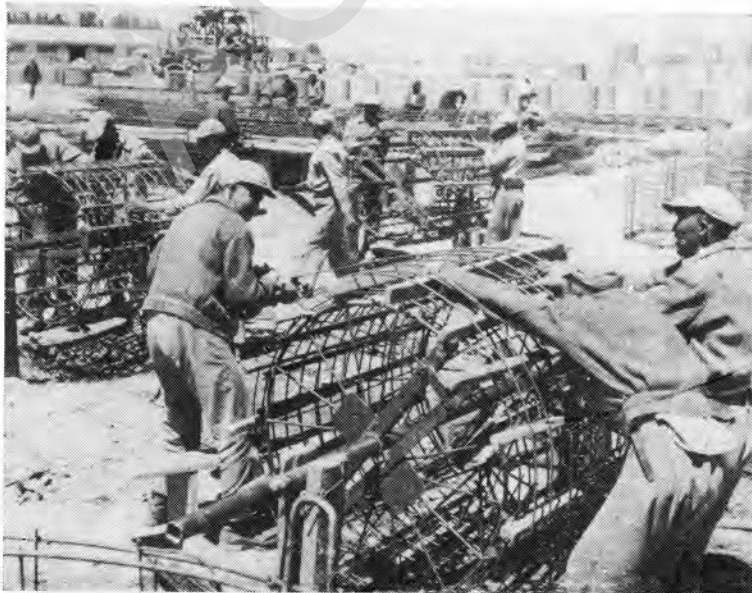
په هرات کښی د بلول جوړولو یوه منظره چه ددغی دستگاہ په واسطه د تور غونډی او کندنه تر منځ دسړک جوړولو او ویالی پوښلو لپاره بلو لونه تهیه کیږی .
