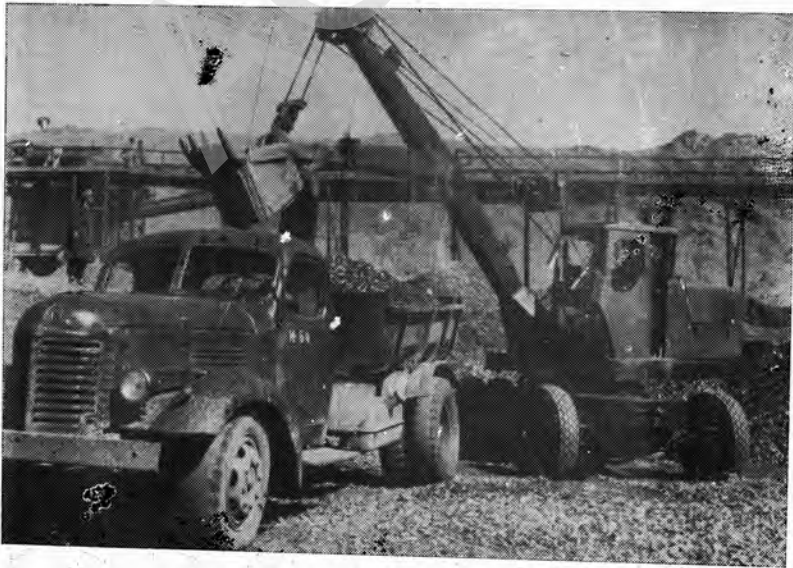
د کابل په هوایی ډگر کښی د ډبری ماتولو یو ماشین د فعالیت په حال کښی
