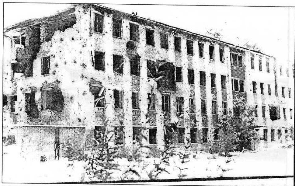
نمای تخریب شده فابریکه جنگلک دهه ۱۳۷۰
