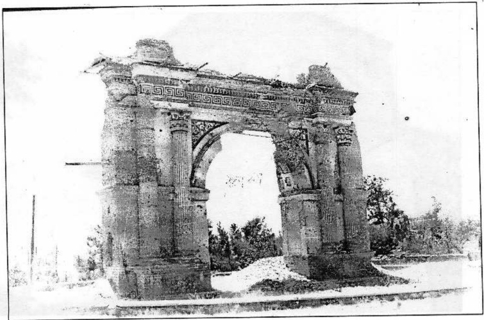
نمای تخریب شده طاق ظفر
