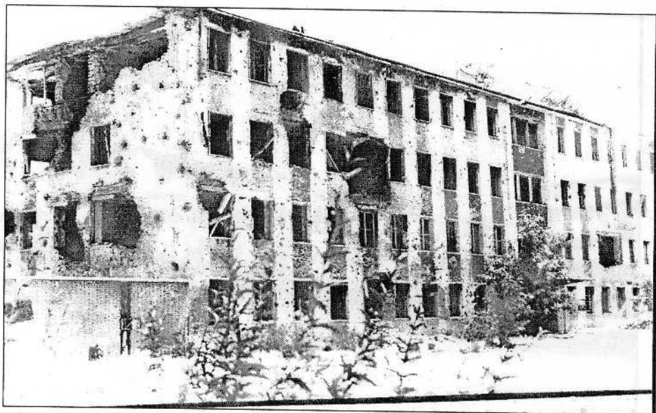
نمای تخریب شده فابریکه جنگلک دهه ۱۳۷۰
