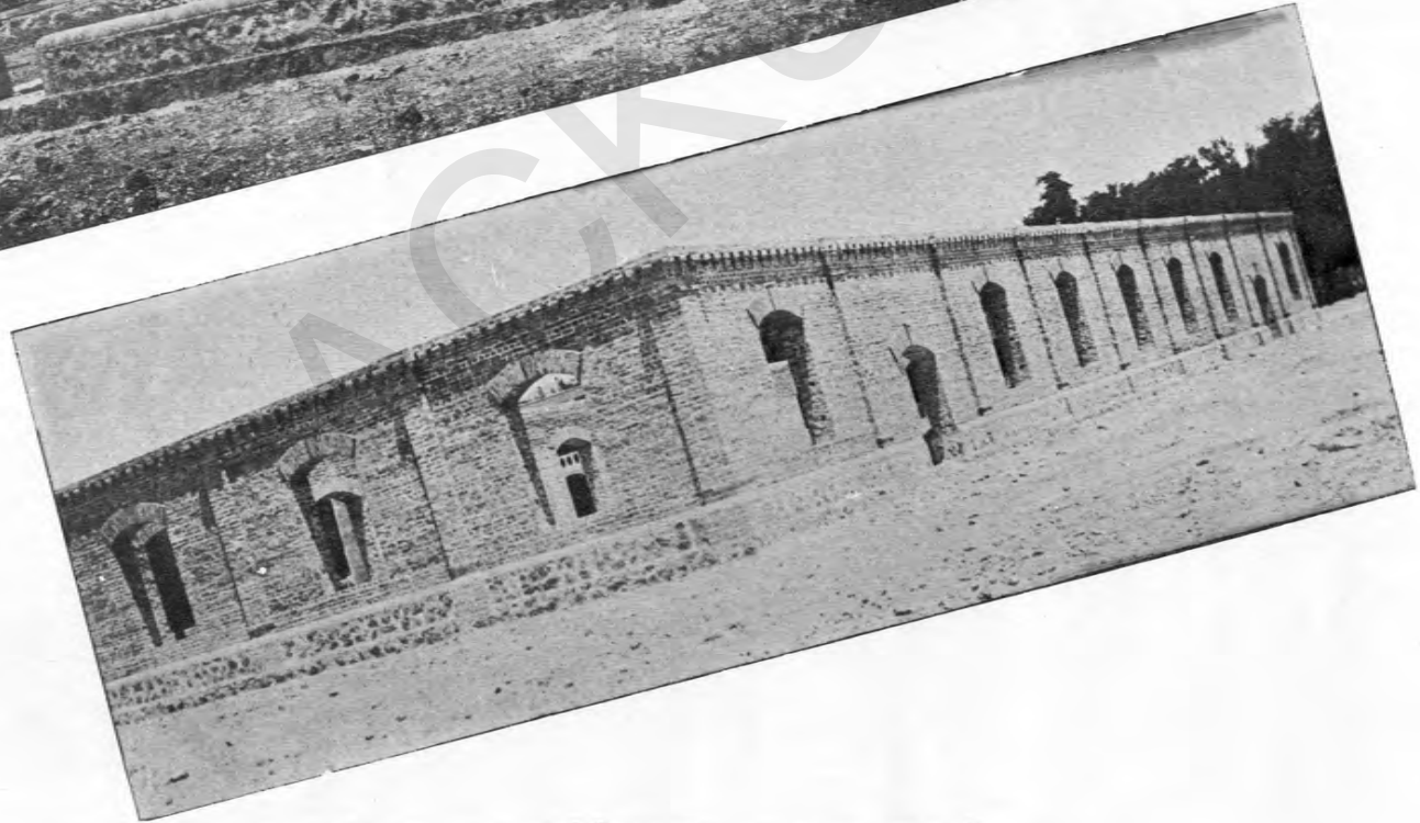
از تعمیرات جدید قندهار بالا : فابریکه فشاریشم پائین : تحویل خانه یشم Nouveaux Fabriques de Lainage, en construction, à KANDAHAR.
