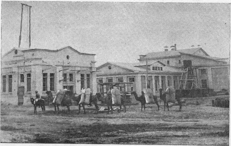
از موسسات اقتصادی جدید در ولایات شمالی: عمارات فابریکة قندوز Vue générale de la faprique de preses et d'emballage de coton à Kondouz «Prov.de Kataghan»
