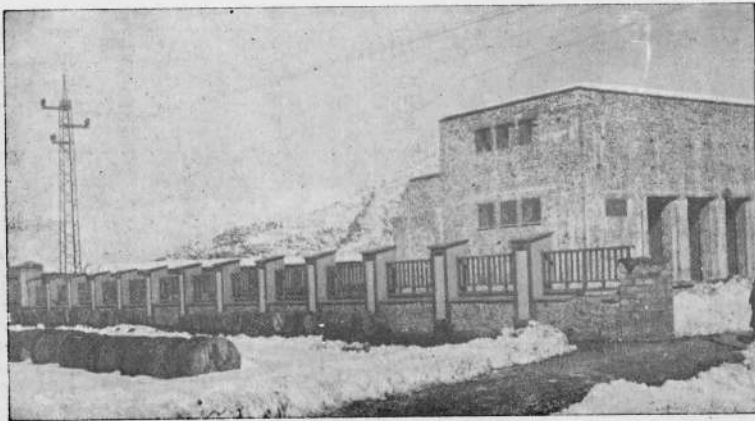
منظره قسمت غربی سب استیشن دهمزنگ
