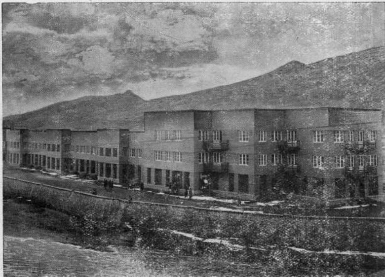
منظره عمومی آپارتمان های جدید که در لب دریای کابل در ۱۳۱۸ ساخته شده
