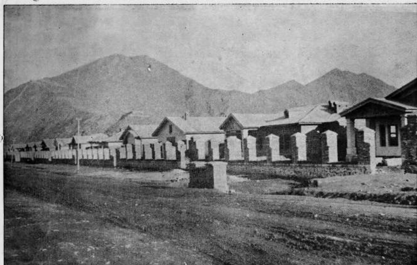
از مناظر نوی کابل : قسمتی از آ پار تمان های جدید تعمیر
