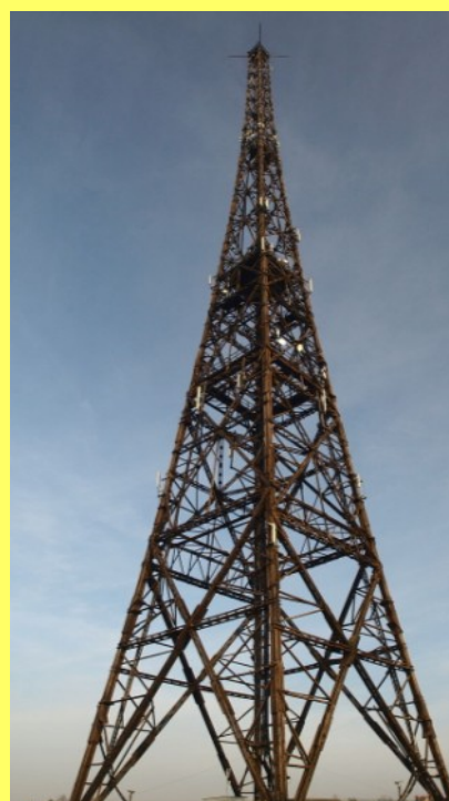
فرستنده ی ایستگاه گایویتس
