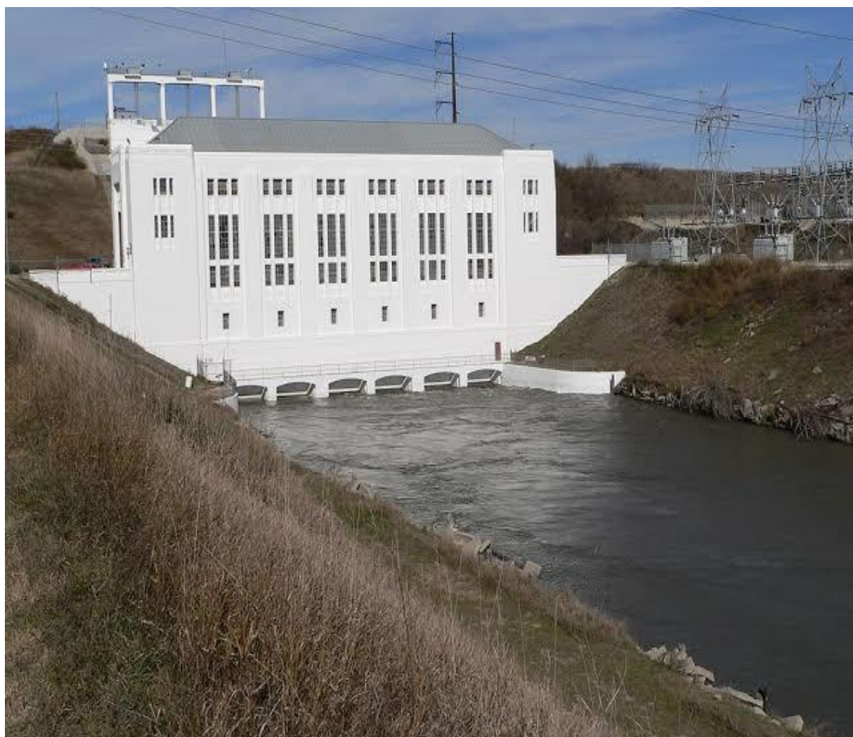
4.7 انځور: خروجي کانال (Tailrace Canal)
