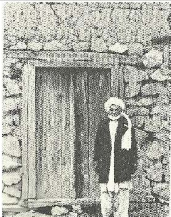
بالا بردن مقاومت دروازه ادخال قلعه توسط سنگ گاری دوطرف آن
