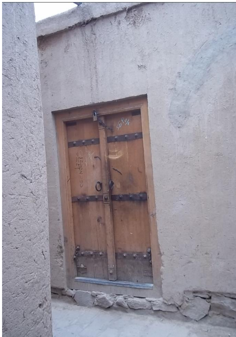
عکس از زنجیر، تگ تک، بینچه، محکم گیرنده (Door stopper) دروازه ادخال یکی از حویلی ها
