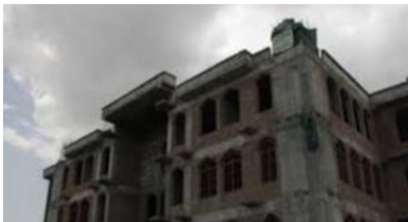
عکس خارجی از مسجد بی بی زینب
