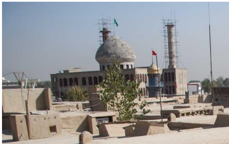
عکس خارجی از مسجد بی بی زینب
