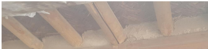
عکس از سقف پیک اتاق بدون مسطح
