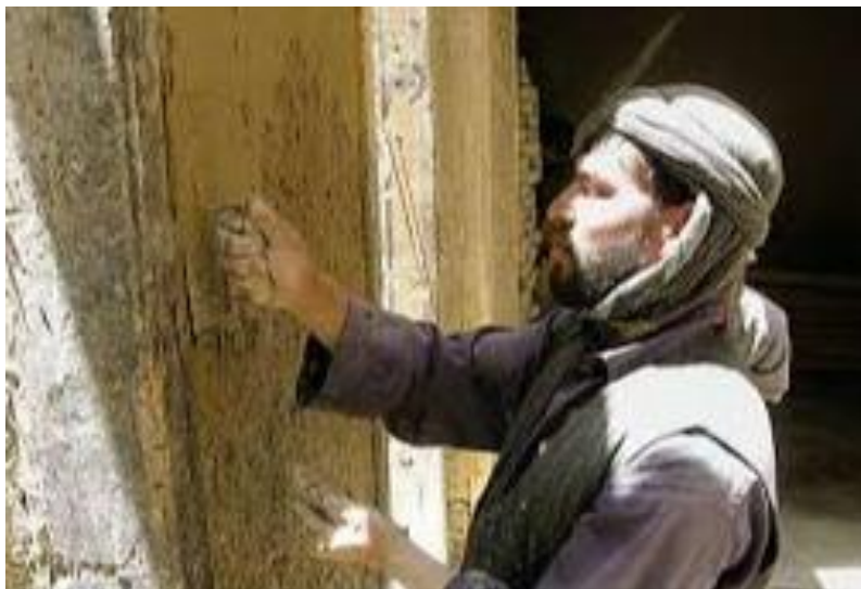
عکس از بازسازی دیوار
