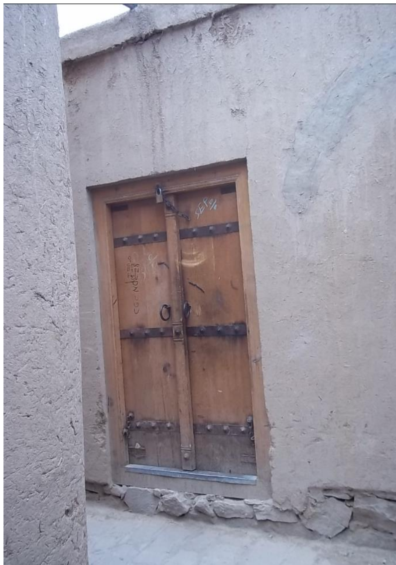
دروازې د ټک ټک زنځیر، پوزې او پلې د درولو (Door stopper) انځور
