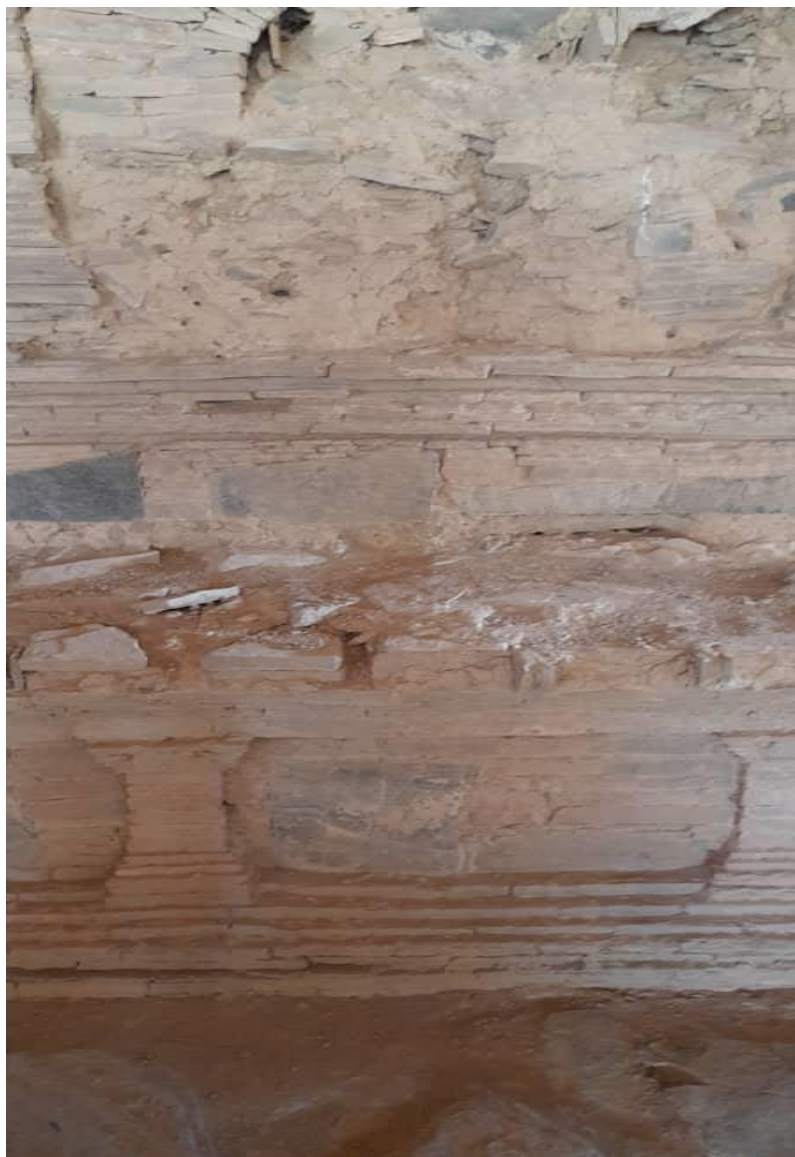
تصویر بخشی از استوپیای منطقه مس عینک
