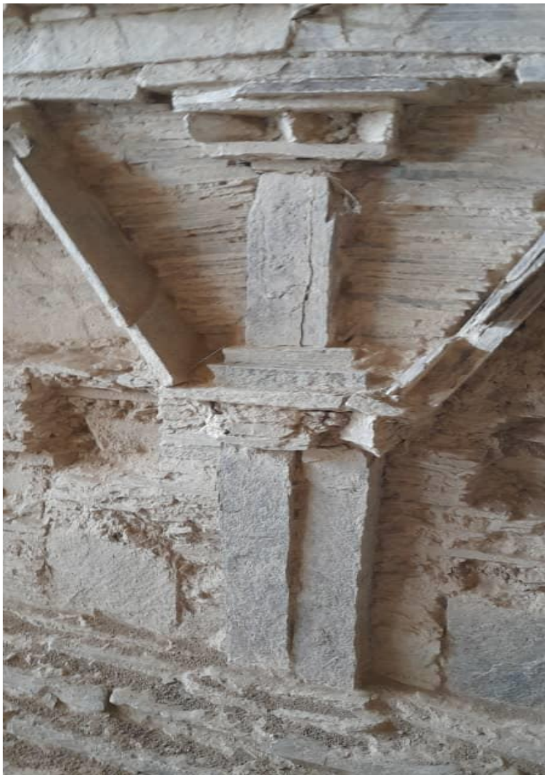
تصویر بخشی از استوای منطقه مس عینک
