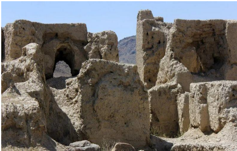
تصویری از ساختمان های مس عینک
