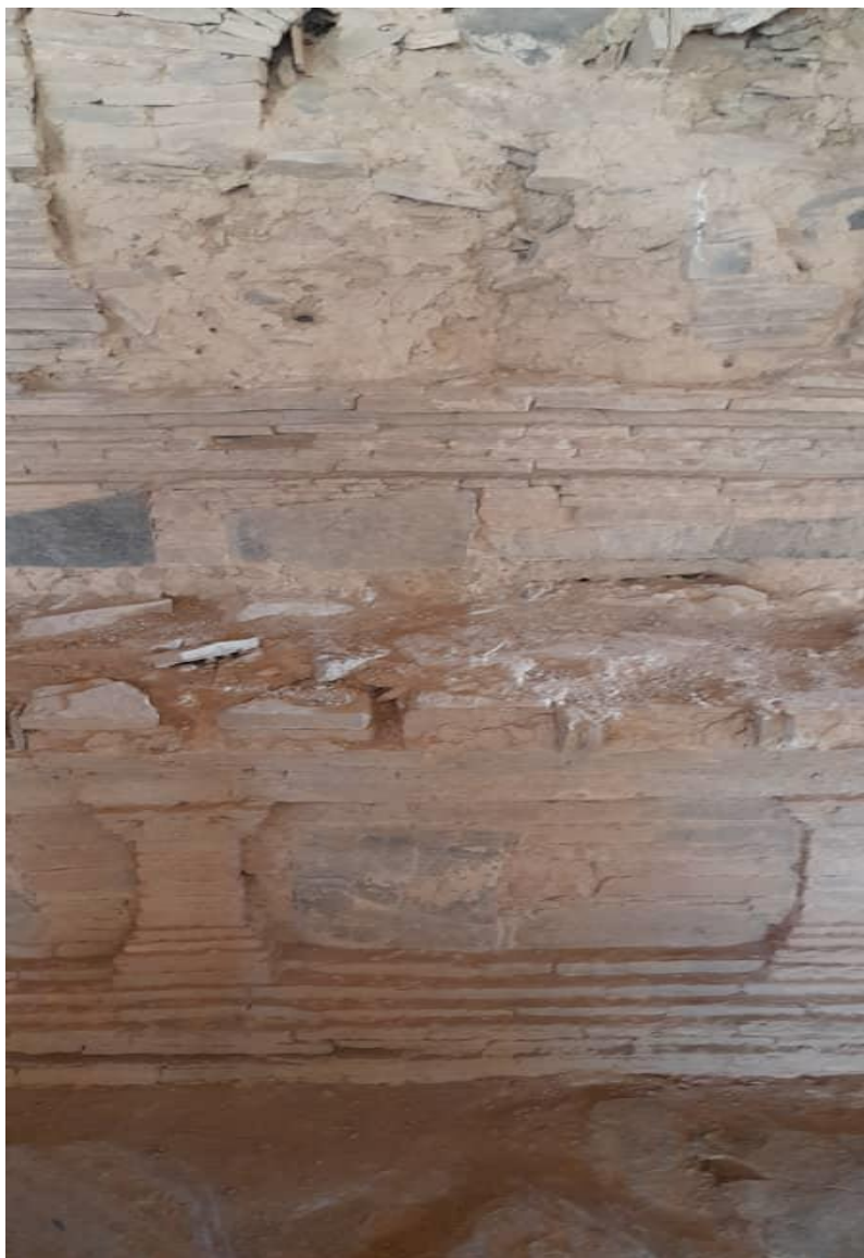
تصویر بخشی از استوای منطقه مس عینک
