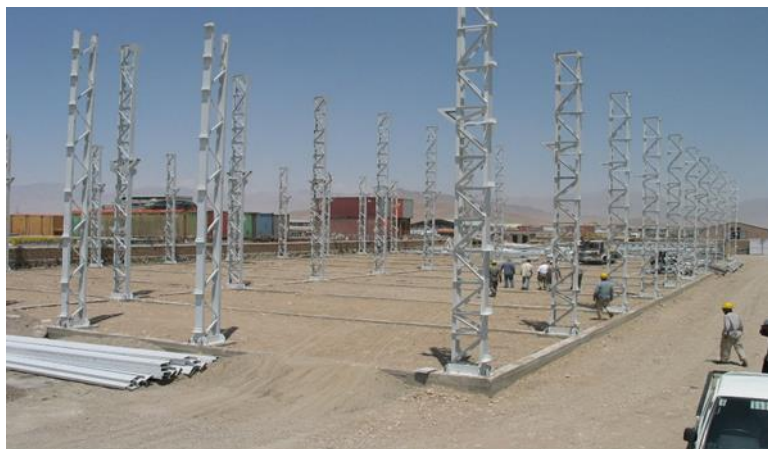
تصویری از ساختمان فابریکه تی آی ام
