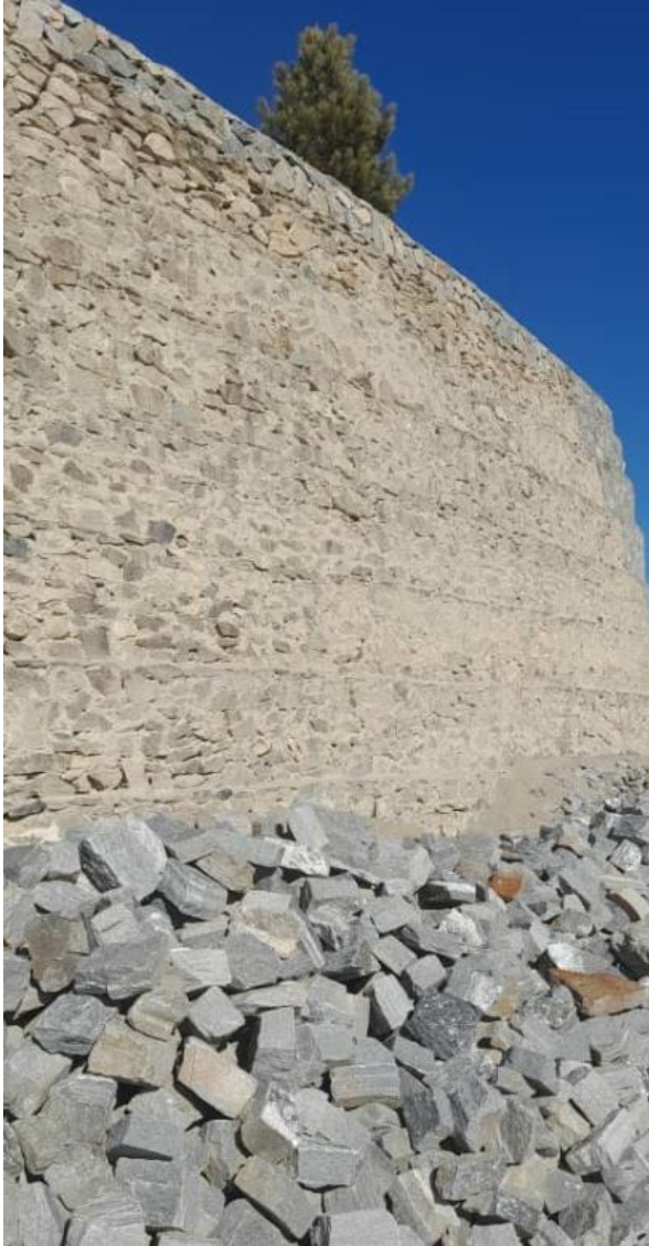
تصویری از قسمت دیوار استنادی برای سرک قلعه بلند
