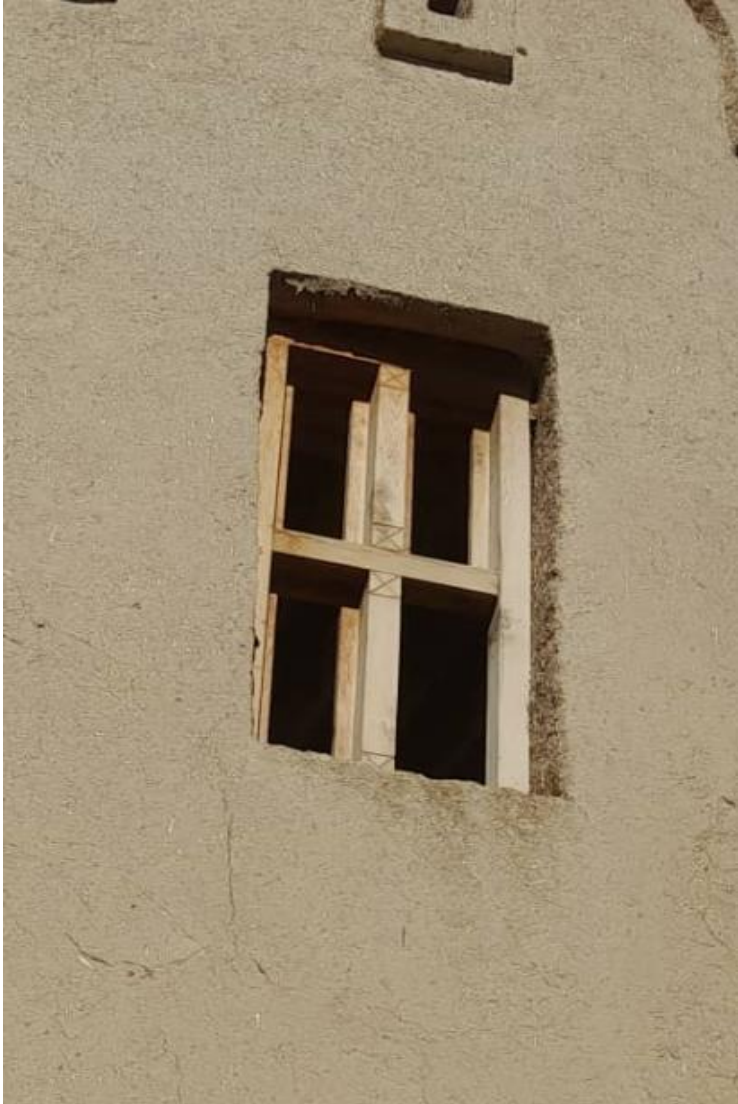
تصویری از قسمت برج های داخلی قلعه
