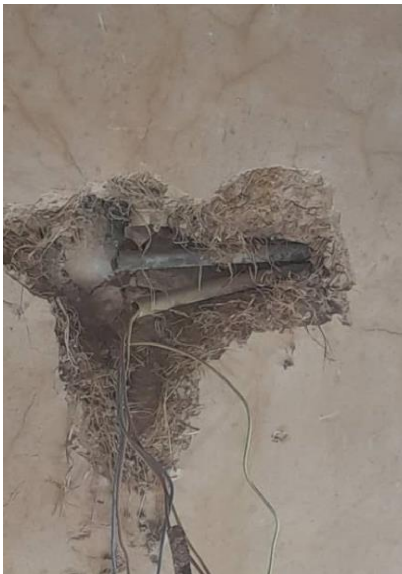
تصویر قسمتی داخلی یکی از تونل‌ها (بونکرها)
