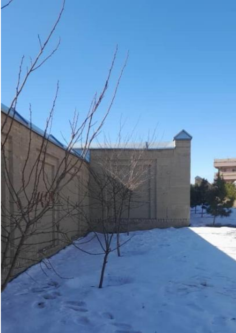
تصویری از دیوار احاطه قسمت سمت جنوب
