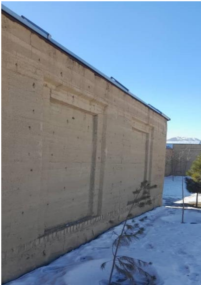
تصویری از دیوار احاطه قسمت سمت جنوب
