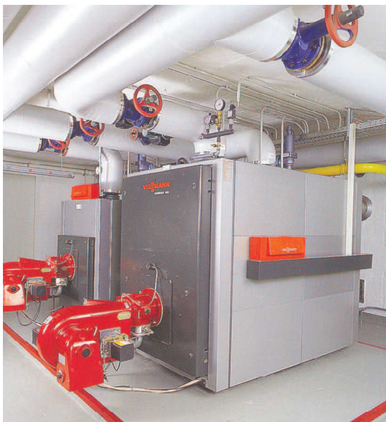
د بایلر د مونتاژ د خوني پوه نمونه (منبع: د فیسمن Viessmann د کمپنی معلوماتي پاڼي)
