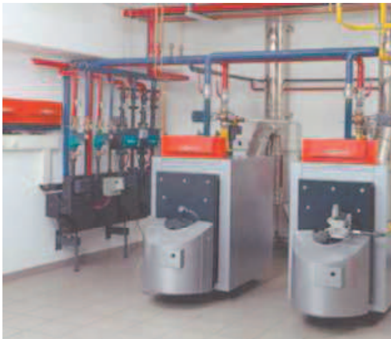
د دوو بایلرو څخه جوړه شوي پوه د ستگاه ، په هغوي پوري تړلي پونټ برنرونه ، پمپ سټیشن اود بایلر د تنظیم او کنترول وسایل (منبع: د فیسمن Viessmann د شرکت معلوماتي پاڼي)
