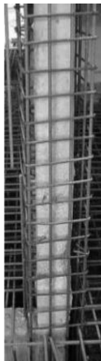
۱- شکل (اوسپنیز کانکریټي تخریب شوی
