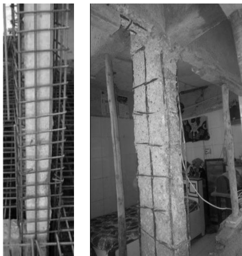
۱- شکل (اوسپنیز کانکریټي تخریب شوی
