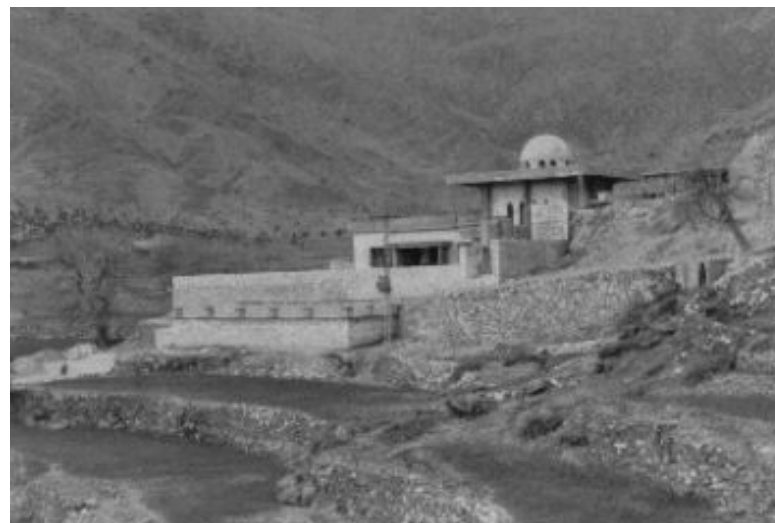
مسجد غازی آباد
