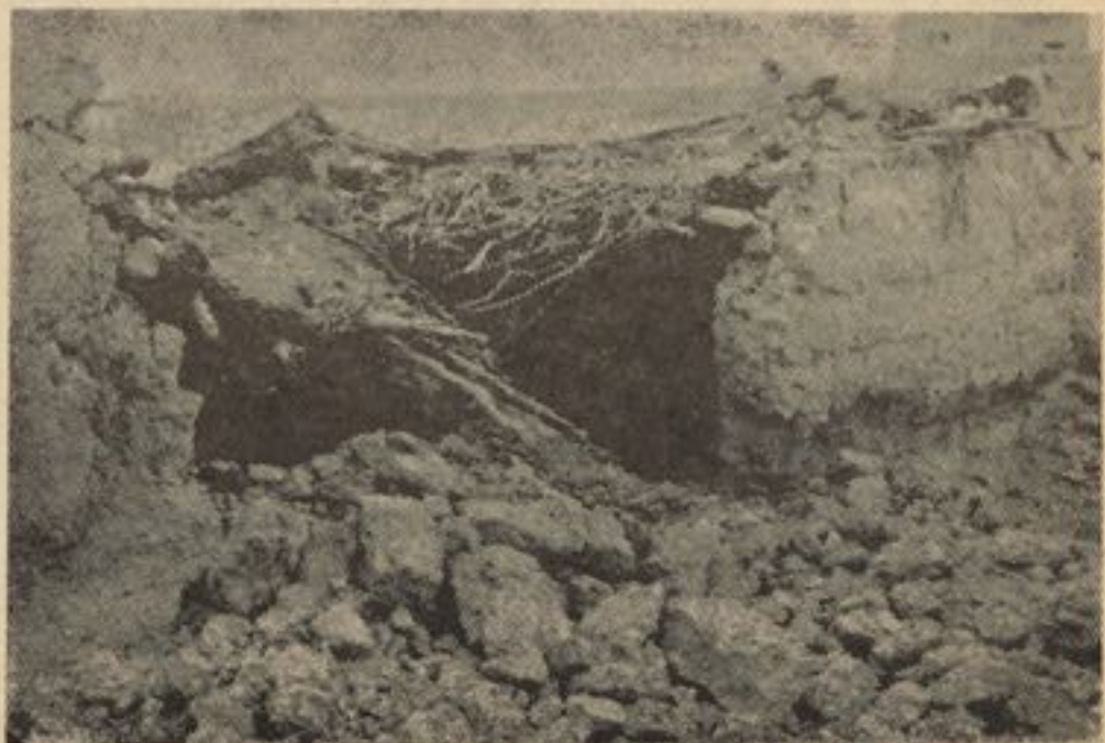
صحنه یی از خرابی زلزله در اشکمش
