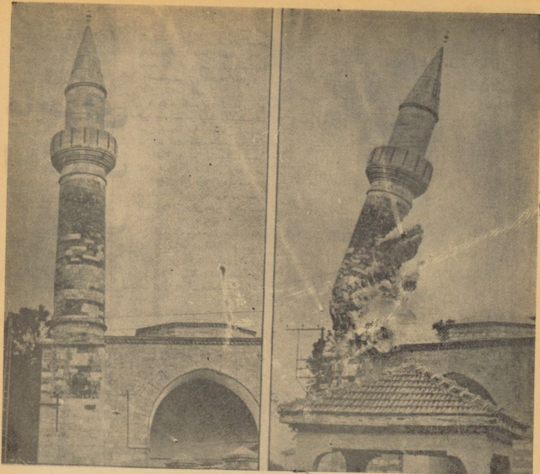
مناره زیبا مسجد تاریخی شهرردوان، در ترکیه که یکی از افتخارات تاریخی مردم شهر بود که در اثر زلزله شدید یکه در آن شهر رخ داد مناره مذکور به خاک یکسان گردید.
