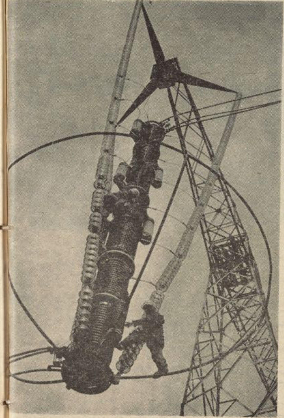
انتقال انرژی برقی ولتاژ های بلندتر که میتواند میلیون ها کلیوات برقی را ذخیره کند البته موجودیت لین های جدید و مقاوم برق حتمی است
