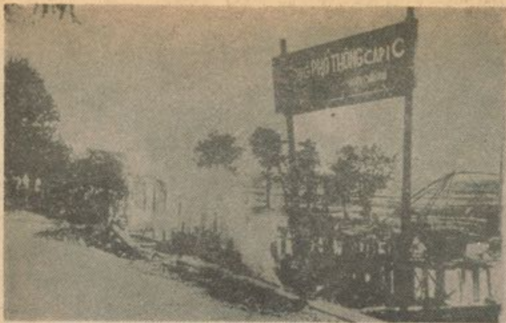
يك مکتب حریق شده در انگیانگ
