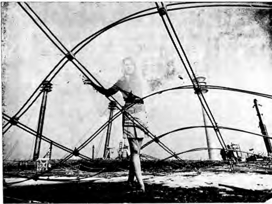
ساختمان استادیوم سرپوشیده مونسشن در مراحل ابتدائی آن
