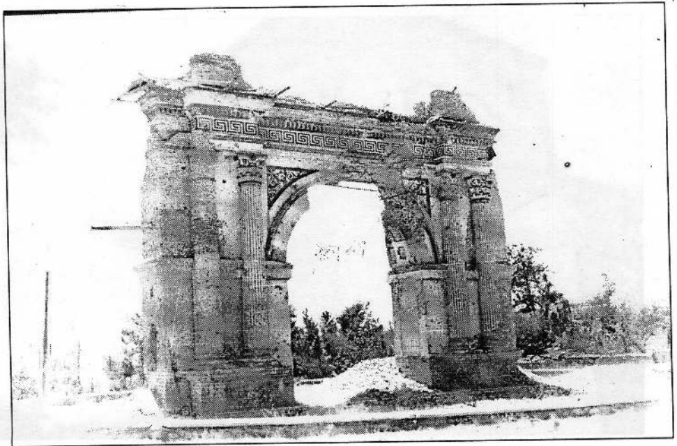
نمای تخریب شده طاق ظفر
