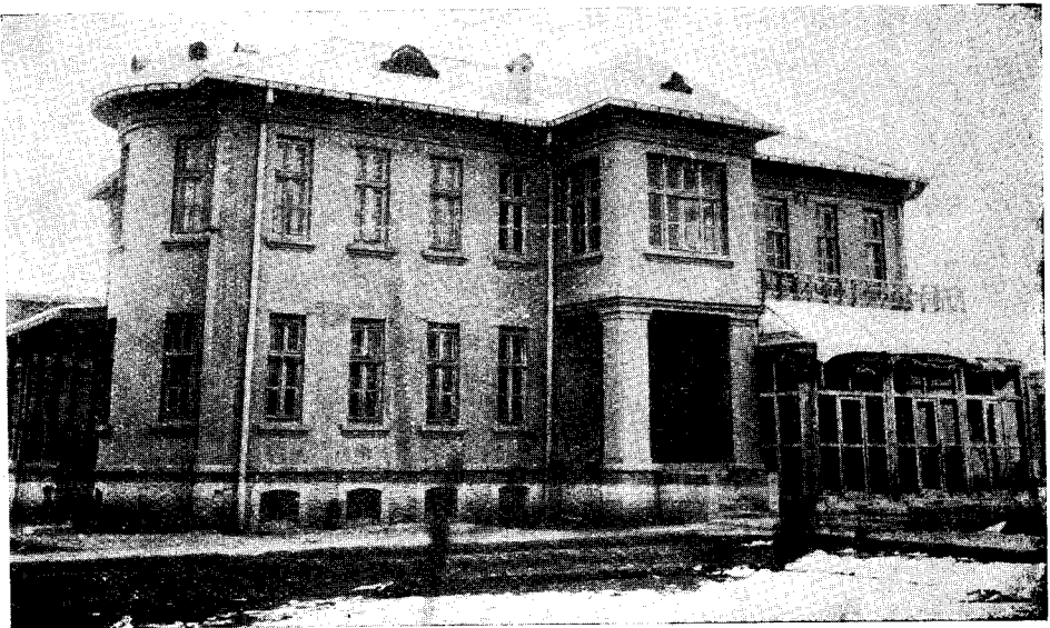
نمونه عمارات جدید یکه حسب نقشه و مساعی بلدیة از طرف مردم در حصه نو ساخت کابل ساخته شده است
