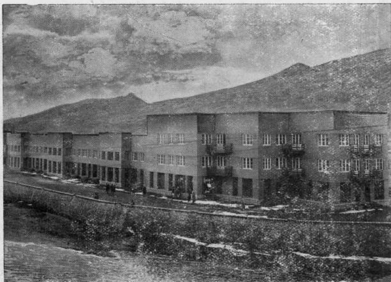
منظره عمومی آپارتمان های جدید که در لب دریای کابل در ۱۳۱۸ ساخته شده
