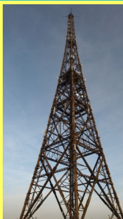
فرستنده ی ایستگاه گایویتس
