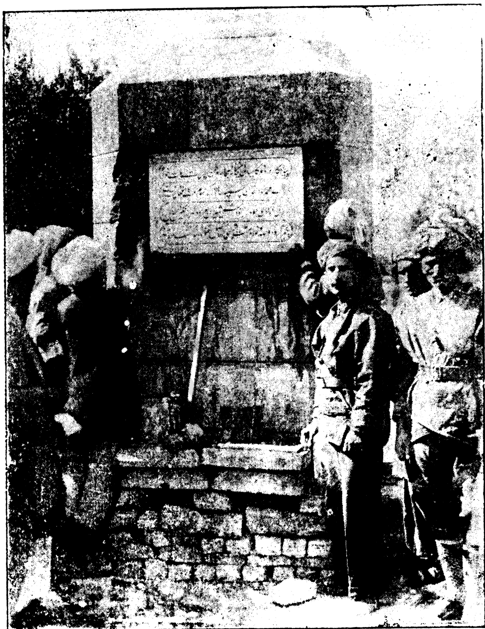
مؤلف - در حال نصب دوباره کتیبه استقلال
