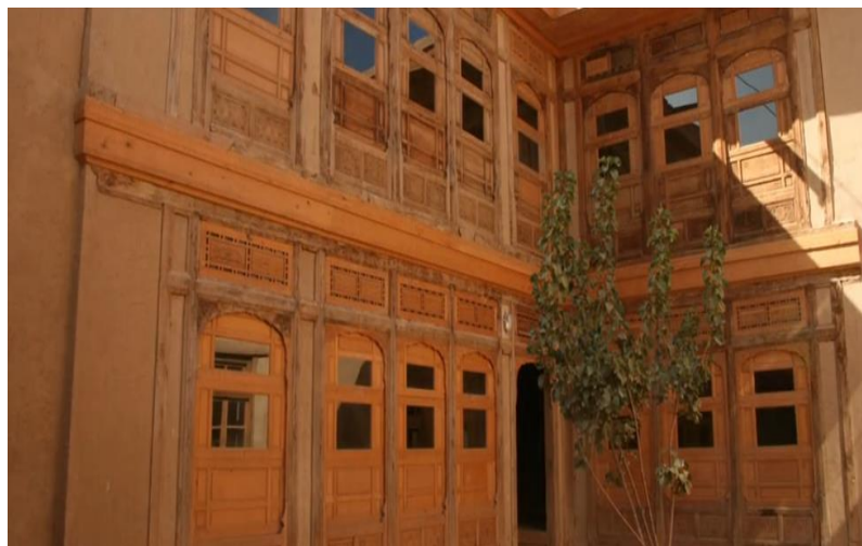
عکس یکی از خانه ها بعد از باز سازی
