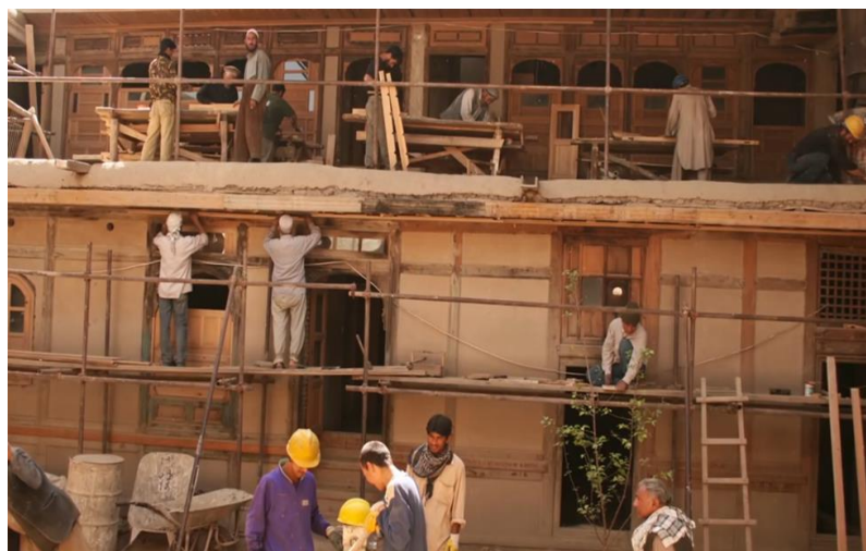
عکس یکی از خانه ها در جریان باز سازی
