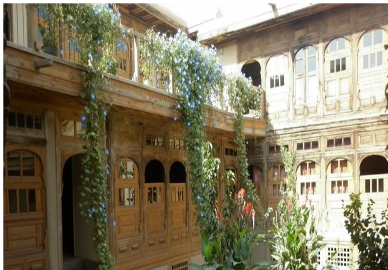
عکس یکی از خانه ها بعد از باز سازی
