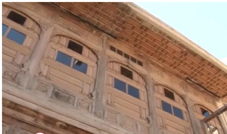
عکس از سقف پیک اتاق با مسطح چوبی
