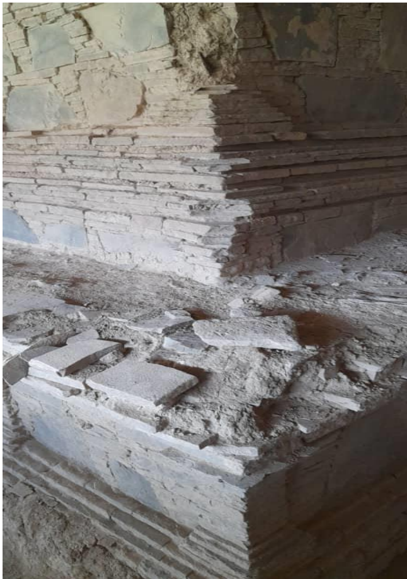
تصویر بخشی از استوای منطقه مس عینک
