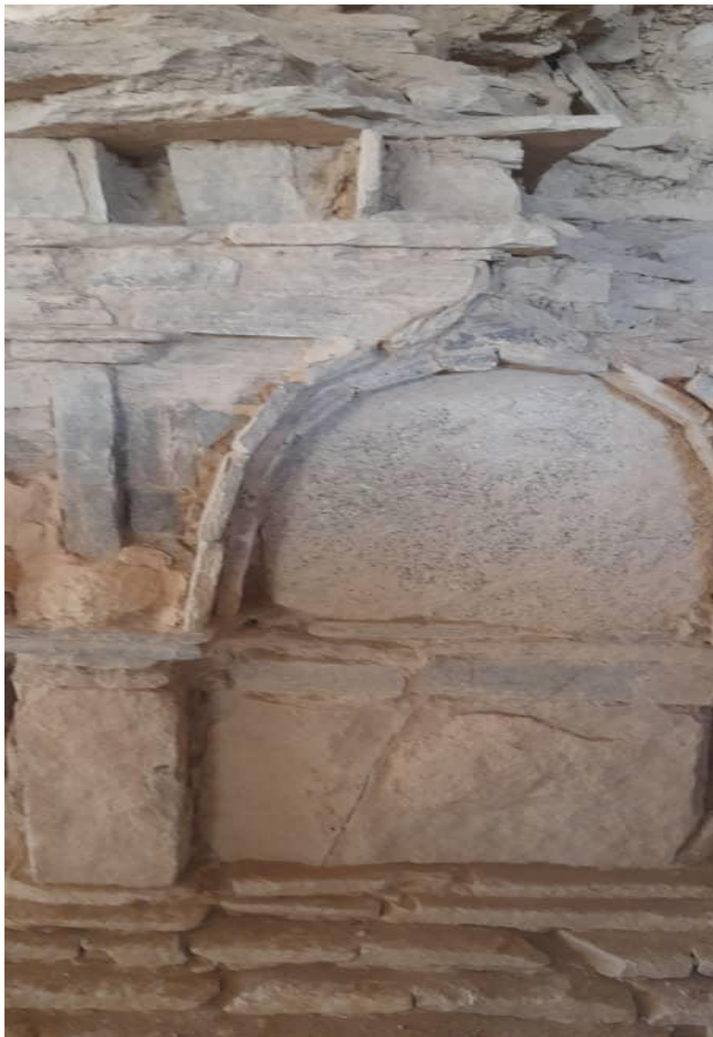
تصویر بخشی از استوای منطقه مس عینک
