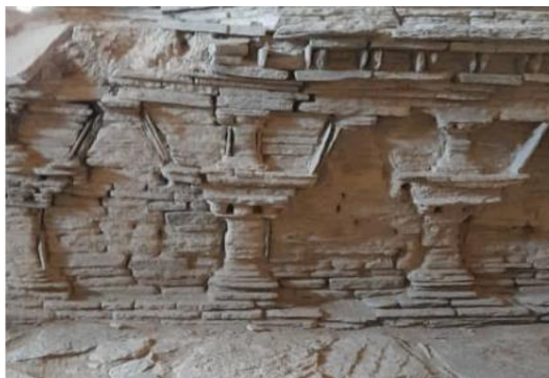
تصویر بخشی از استوپای منطقه مس عینک
