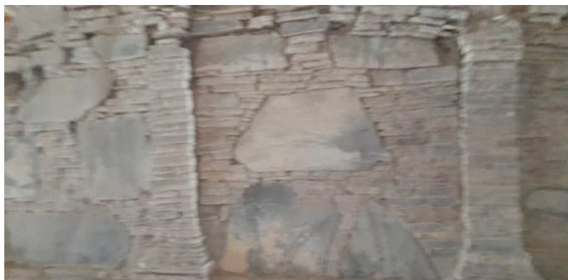
تصویر بخشی از استوپای منطقه مس عینک
