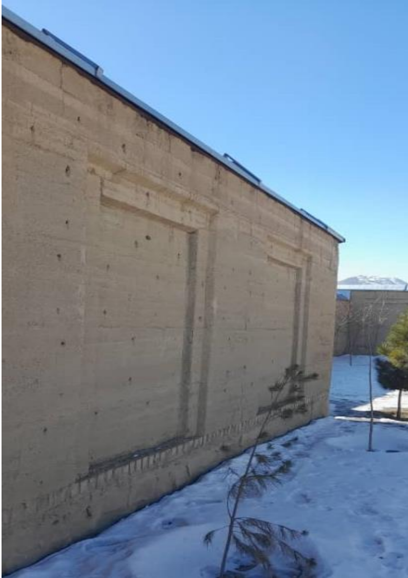
تصویری از دیوار احاطه قسمت سمت جنوب
