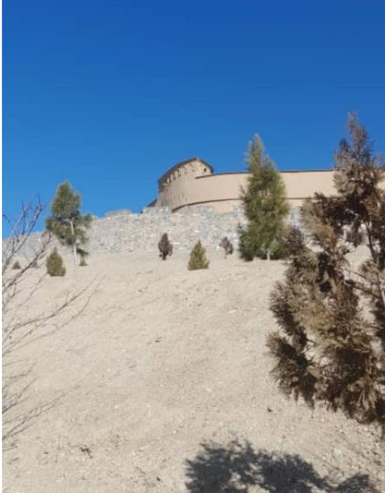
تصویری از قسمت بیرونی برج داخلی قلعه
