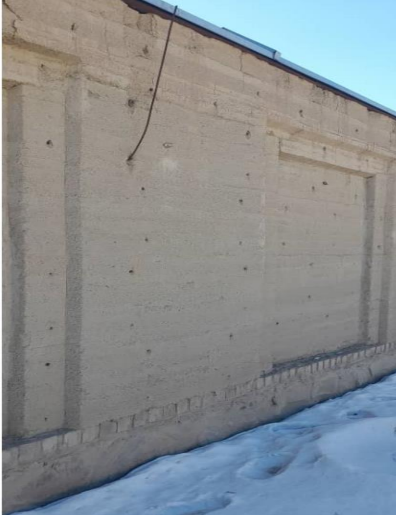
تصویری از دیوار احاطه قسمت سمت جنوب
