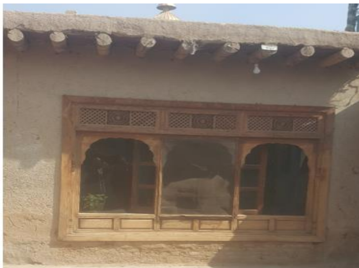
ساخت و نصب کلکین های قدیمی توسط دستگاه انجینری فیروز کوه ( مراد خانی )
