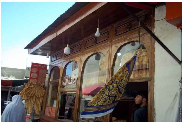
ساخت و نصب کلکین های قدیمی توسط دستگاه انجینری فیروز کوه ( مراد خانی )
