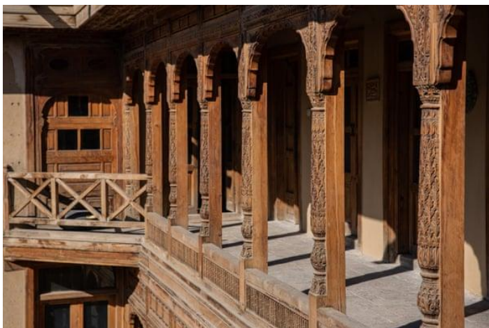
ساخت و نصب پایه در دفتر فیروز کوه ( مراد خانی)
