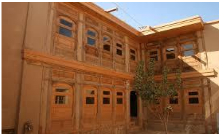
ساخت و نصب کلکین های قدیمی توسط دستگاه انجینری فیروز کوه ( مراد خانی )
