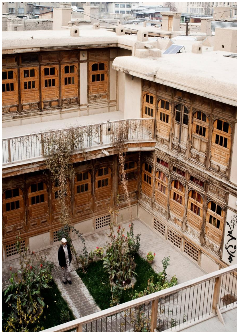
ساخت و نصب کلکین های قدیمی توسط دستگاه انجینری فیروز کوه ( مراد خانی )
