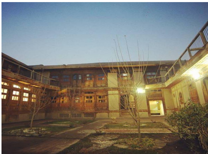
ساخت و نصب کلکین های قدیمی توسط دستگاه انجینری فیروز کوه ( مراد خانی )
