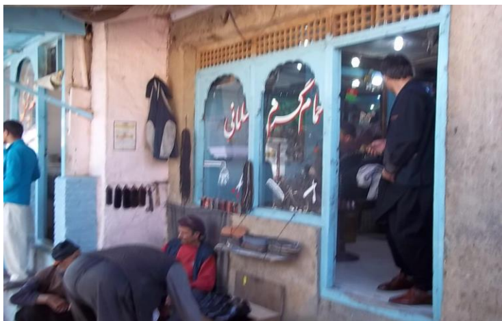
ساخت و نصب کلکین های قدیمی توسط دستگاه انجینری فیروز کوه ( مراد خانی )
