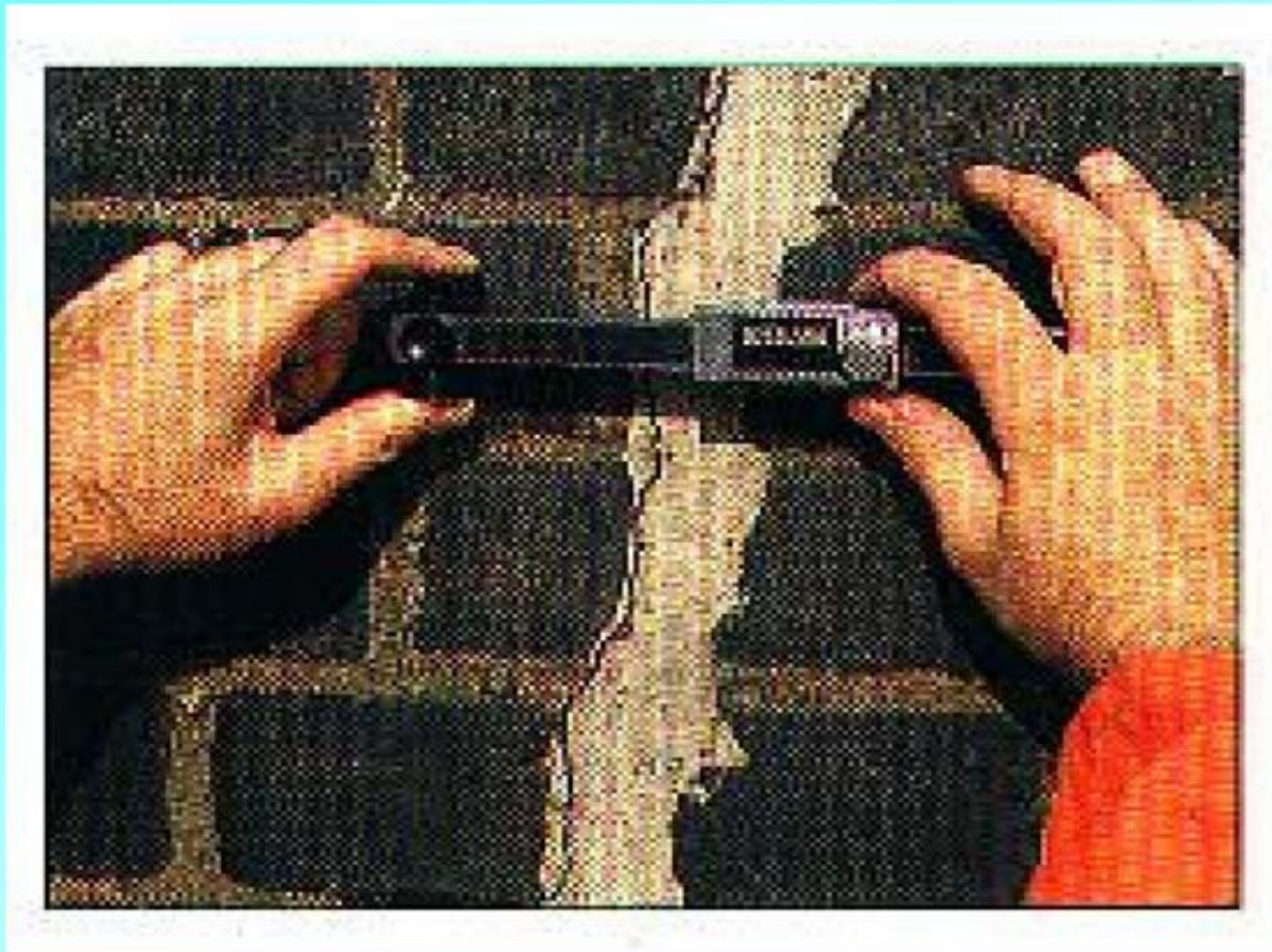
DIGITAL CRACK GAUGE - ELE
