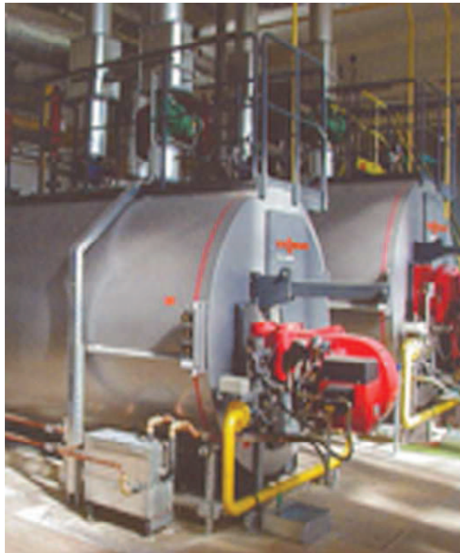
د جوش اوبو او بخار د توليدولو بايلر چي د فيسمن (Viessmann) د شرکت له خوا بازار ته وړاندي کېږي
