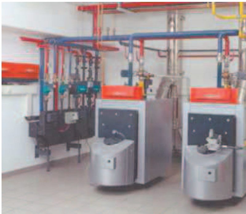
د دوو بایلرو څخه جوړه شوي پوه د ستگاه ، په هغوي پوري تړلي پونټ برنرونه ، پمپ ستیشن اود بایلر د تنظیم او کنترول وسایل (منبع: د فیسمن Viessmann د شرکت معلوماتي پاڼي)
